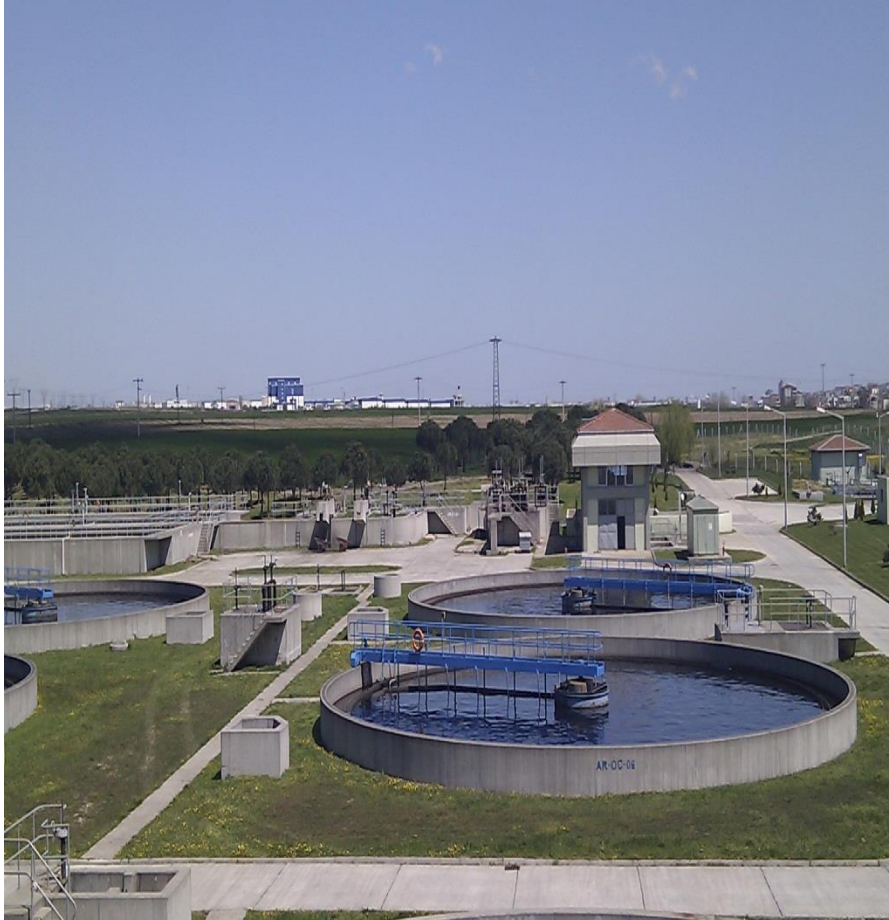
1. Kısım Ön Çöktürme Havuzu
