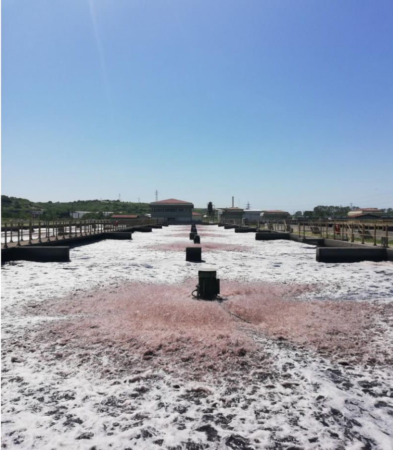
1.Kısım Havalandırma Havuzu
