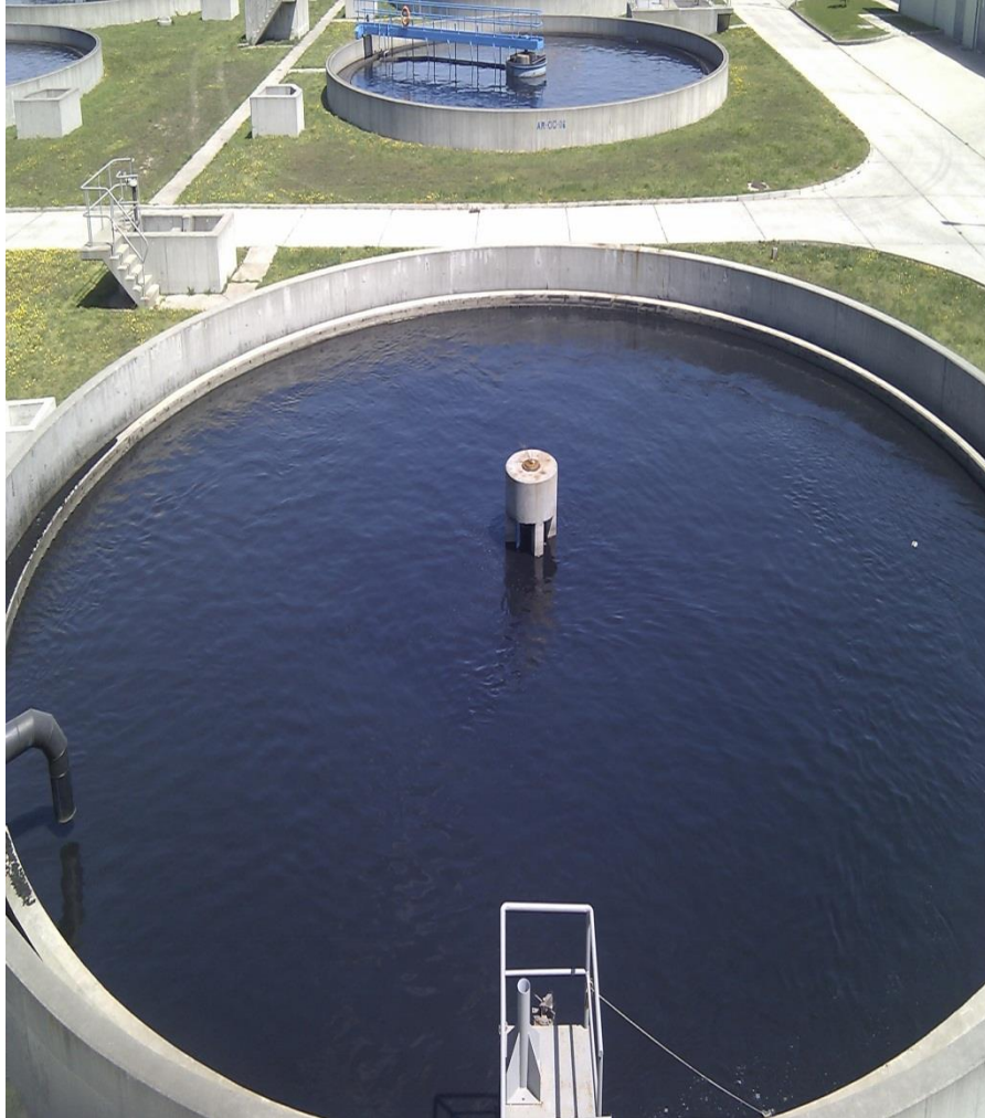
1.Kısım Biofosfor Havuzu
