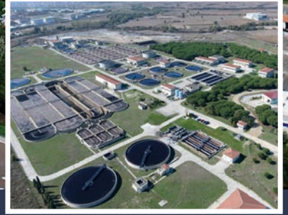
ÇOSB Endüstriyel Atık Su Arıtma Tesisi
